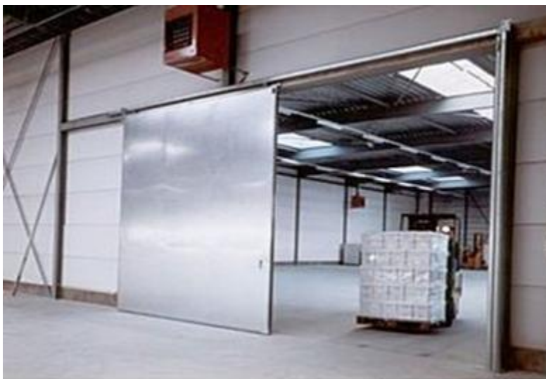
Hình D.2 – Ví dụ về cửa trượt theo phương nằm ngang (Horizontal Sliding Door)
