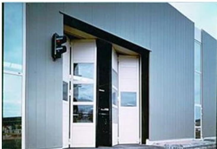
Hình D.6 - Ví dụ về cửa trượt cánh gấp kích thước lớn (Sliding folding door)
